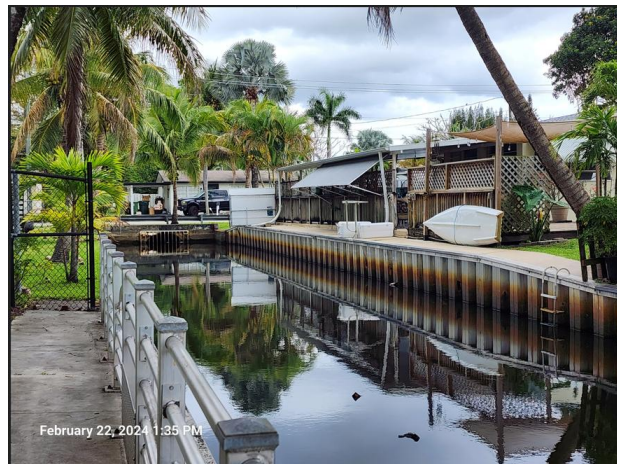
Figure 2.5.7 Channel End (WALL 36)
